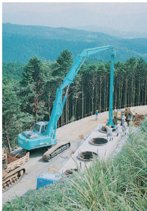
能根据需要高效率进行深挖作业的L·M·C（超长臂抓斗挖掘机）。挖斗为壳式推进式。
